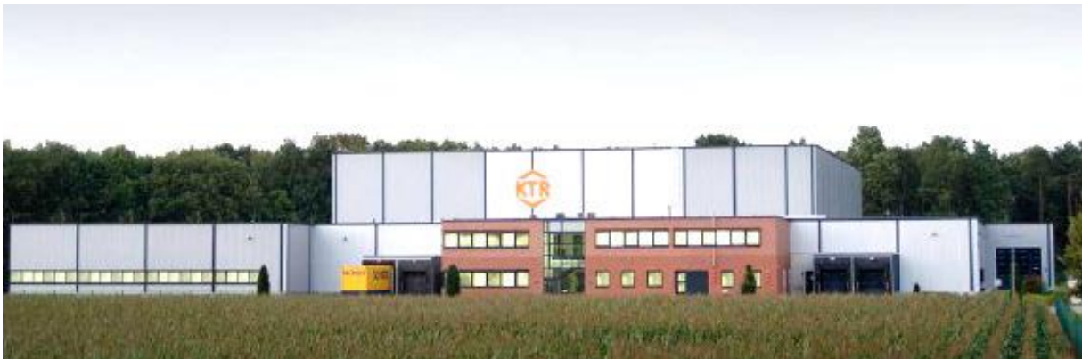
Abbildung 1: Logistikzentrum KTR Systems GmbH
