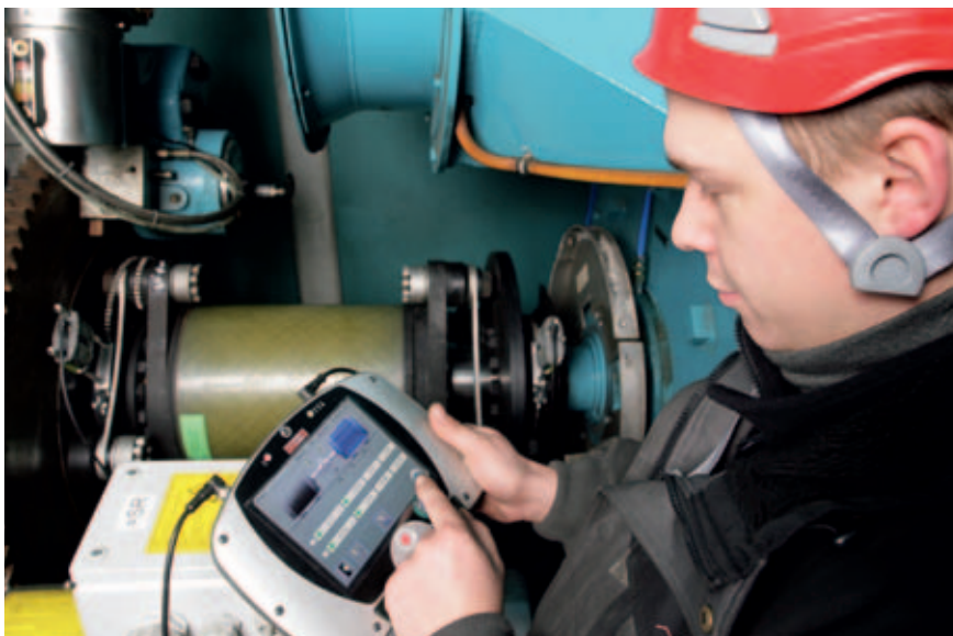
SSB Servicetechniker beim Ausrichten einer isolierten Kupplung.
